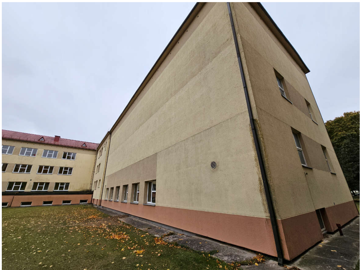
Pav. Remontuojamos pastato daliese vaizdas iš išorės
